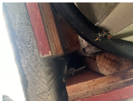
Kontroll av et ytterhjørne
