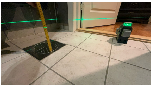
Målt fra dør og til nærmeste sluk
