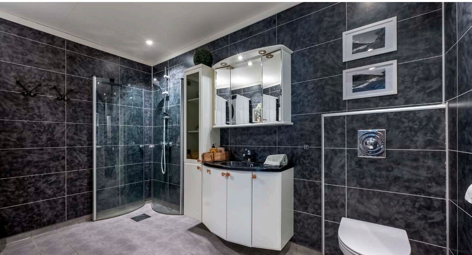
Badet i 1. etasje har flislagt gulv og våtromsplater på vegger
