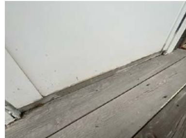
Værslitasje i bunn av balkongdør
