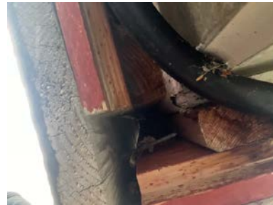
Kontroll av et ytterhjørne
