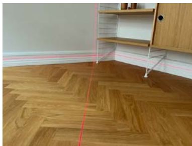
Etasjeskille er kontrollert med krysslaser
