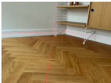
Etasjeskille er kontrollert med krysslaser
