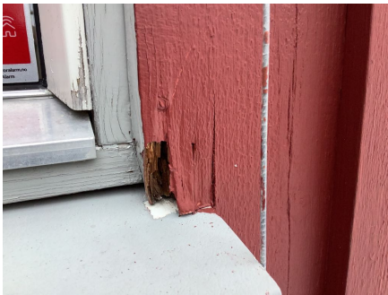
Råteskadet omramming.
