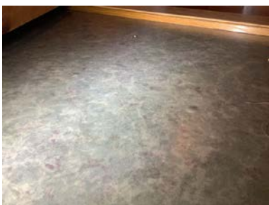
Eksempel på kuler i vinylbelegget.
