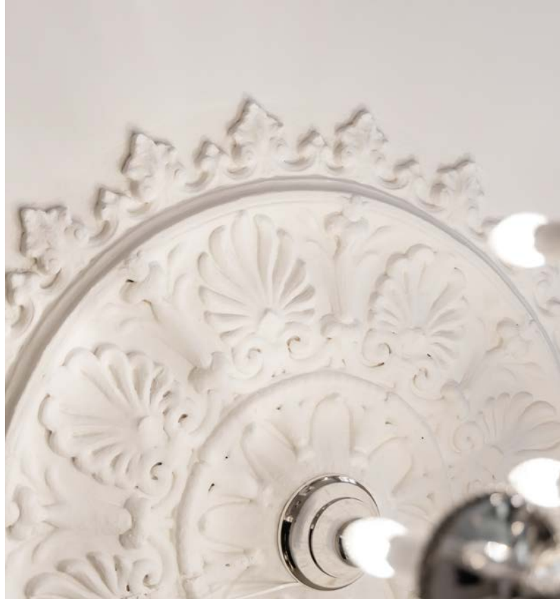
Detalj bilde av rosett i stuen
