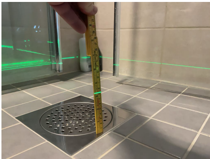
Målt fall til sluk: 31mm.
