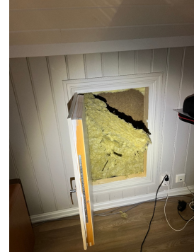
Luker til kneloft er tett med vindtettplate.
