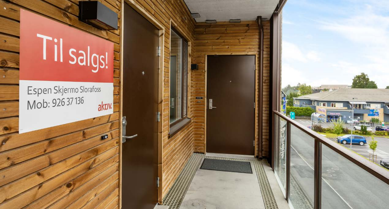
Det er trappefri adkomst via heis opp til etasjeplanet
