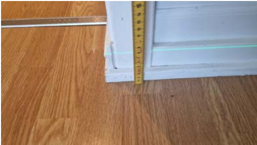
Kontroll av planavvik.
