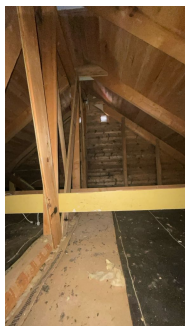
En stk lufterventil observert i gavelvegg.
