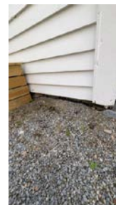
Lav høyde mellom grunnen og kledning, risiko for skader. Anbefalt høyde mellom terreng og kledning er 30 cm.
