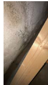
Det er påvist indikasjoner på noe fuktgjennomtrenging i kjellergulv.
