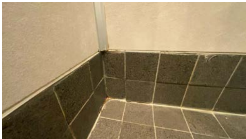
Ujevnheter på i sokkel fils i dusj.
