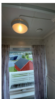
Ventil i himling, ventil i vindu og åpningsvindu
