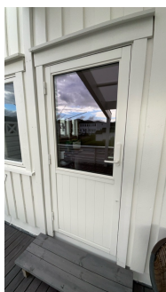
Balkongdør med utgang fra stue fra 2008
