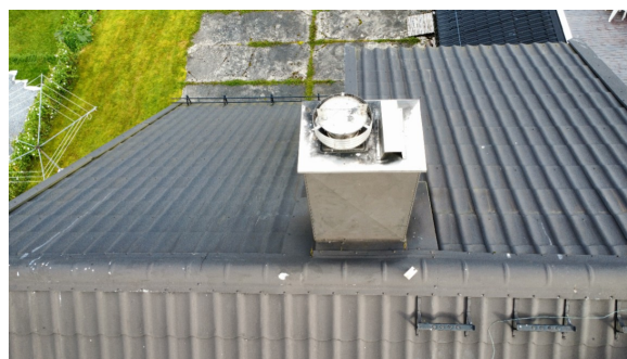
Oversikt pipe til leilighet A og leilighet B
