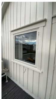
Vindu på stue er ikke mulig å åpne. Punktert glassrute
