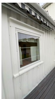
Vindu på stue er ikke mulig å åpne. Punktert glassrute
