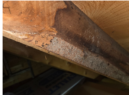
Det er sirkelrunde 1-2 mm store hull i takkonstruksjon som følge av stripet borebille.
