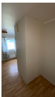
Soverom loft er pipe kledd med tapet
