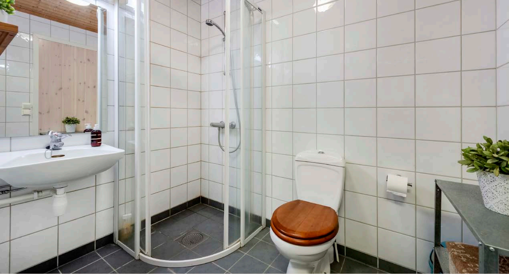
Flislagt bad i sokkel
