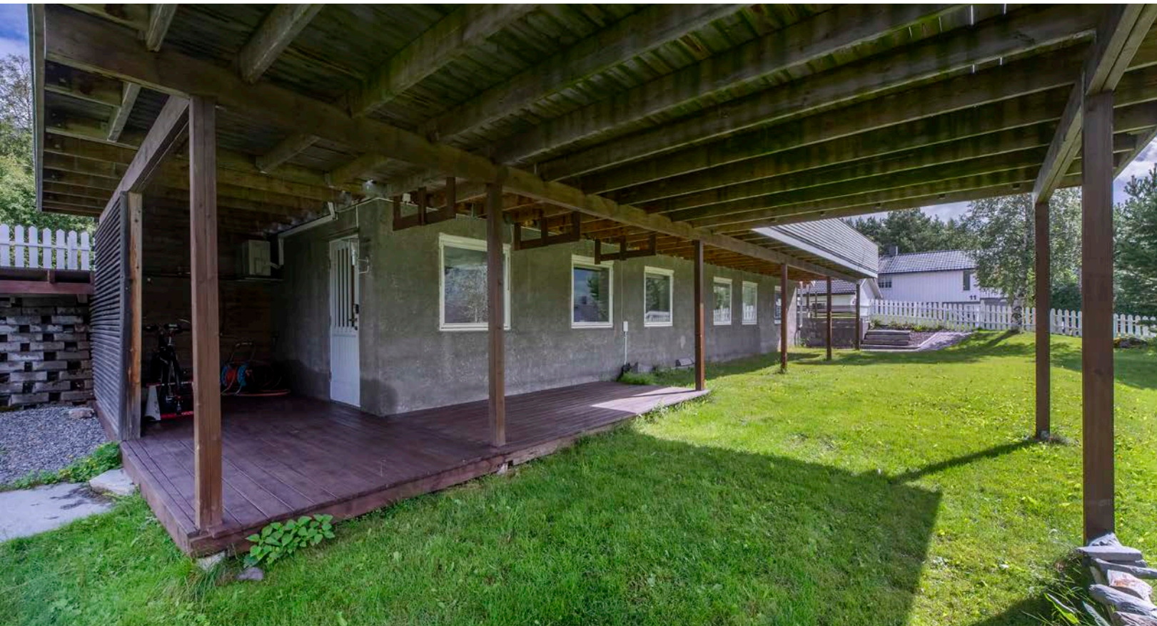
Takoverbygd terrasse med inngang til sokkel mot vest
