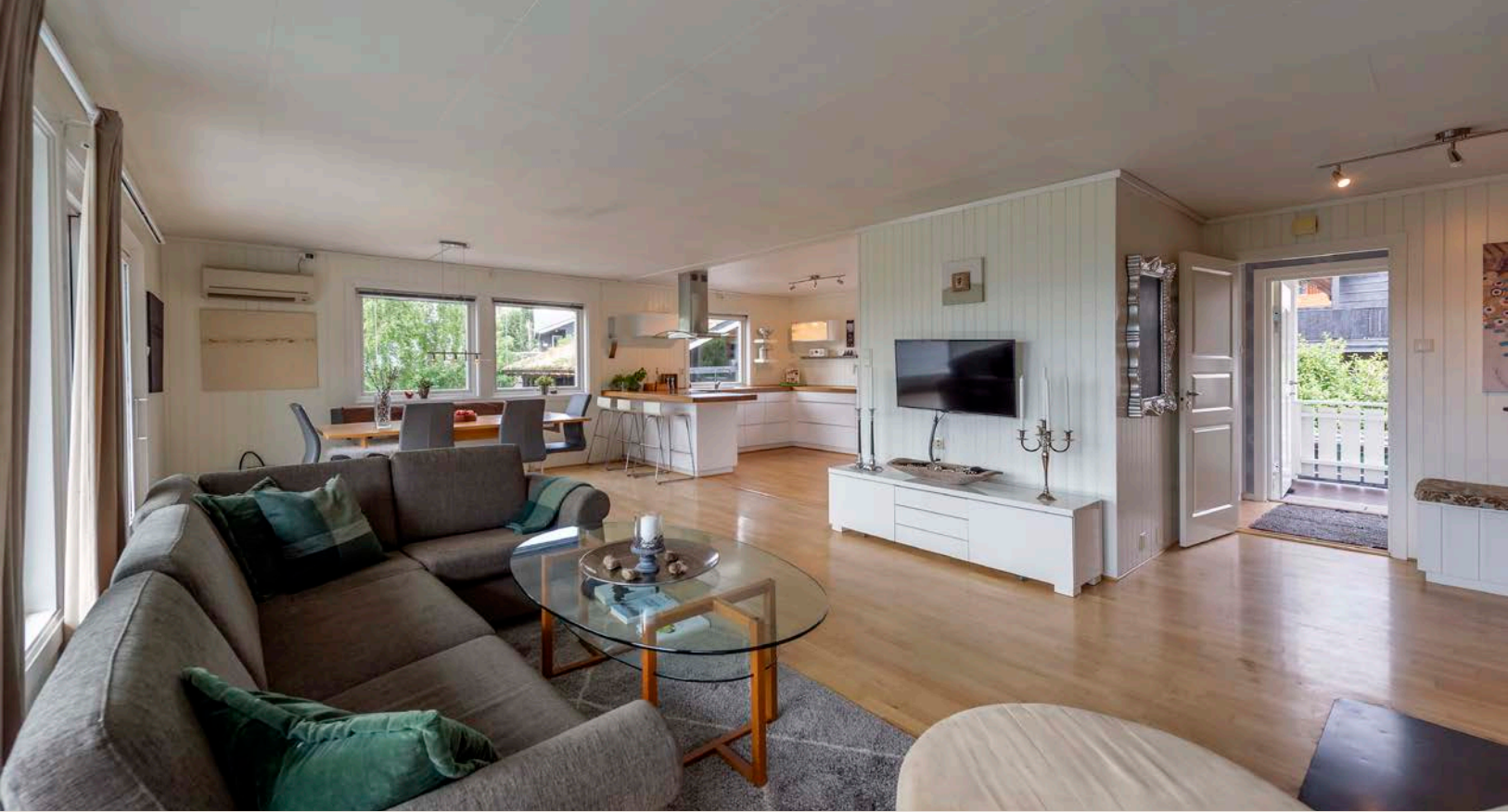
Motsatt ende av stua har varmepumpe
