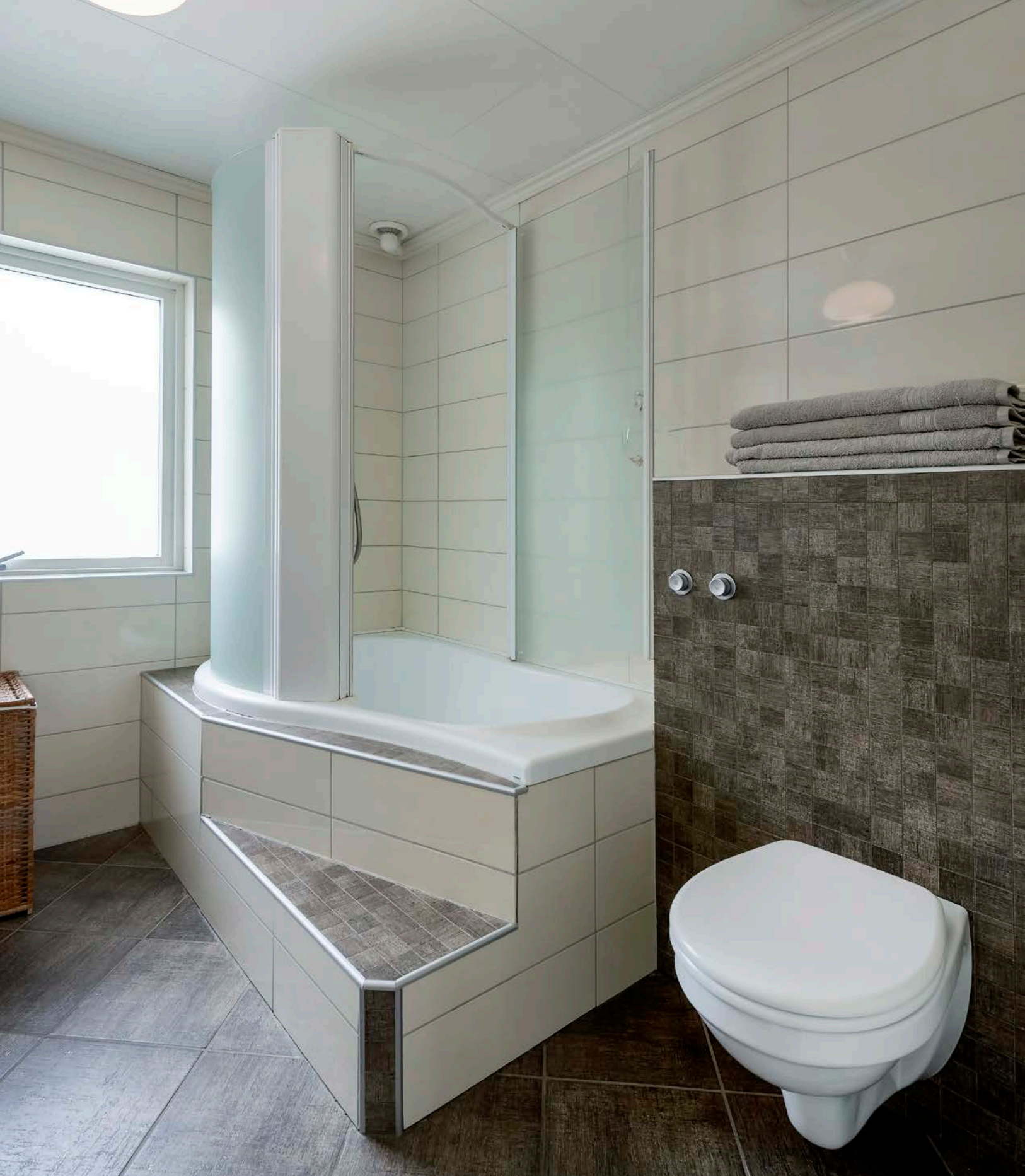
Innbygd badekar med dusjvegger samt vegghengt wc
