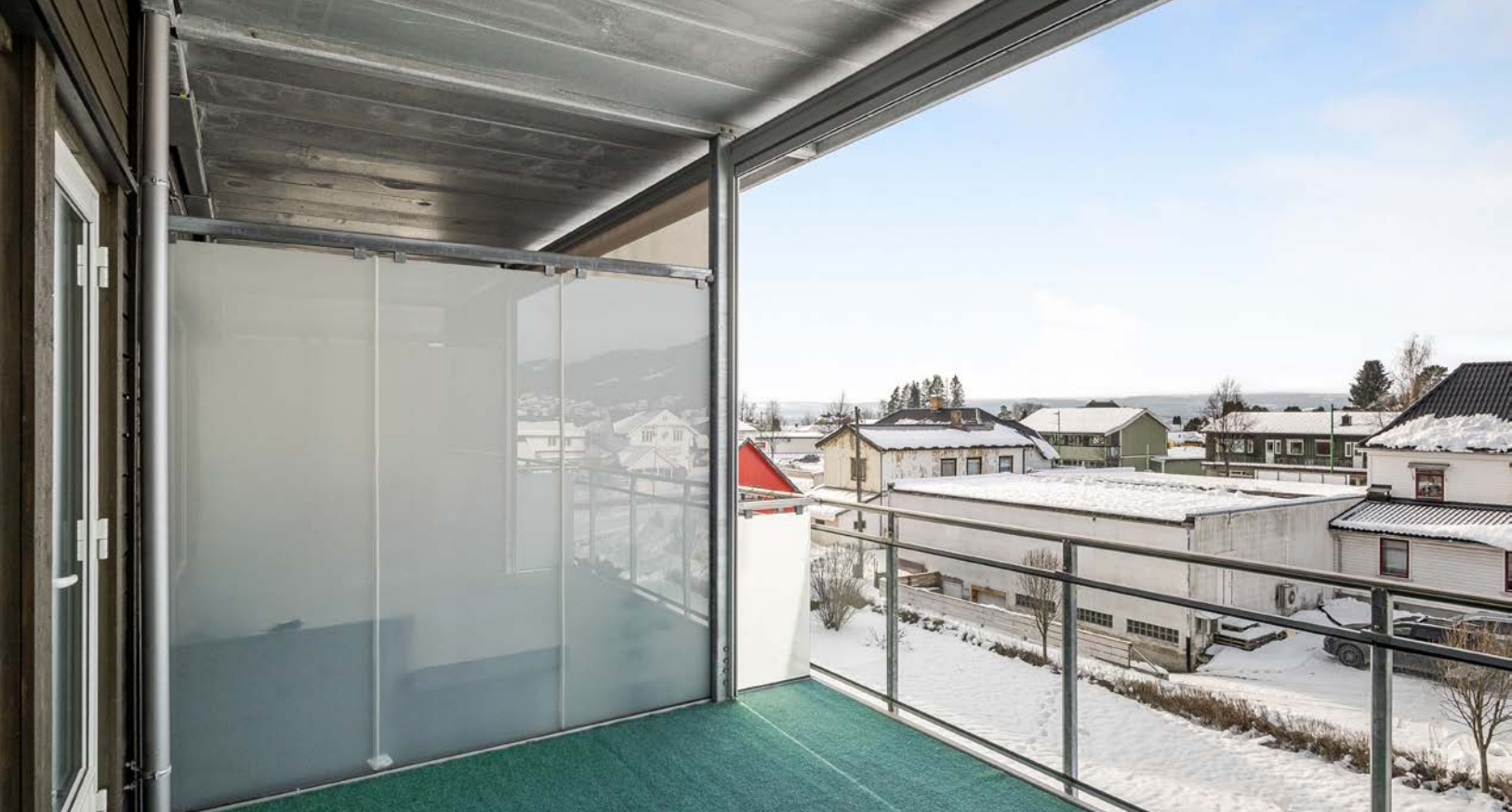
Det er glassrekkverk og teppebelagt gulv på balkongen.
