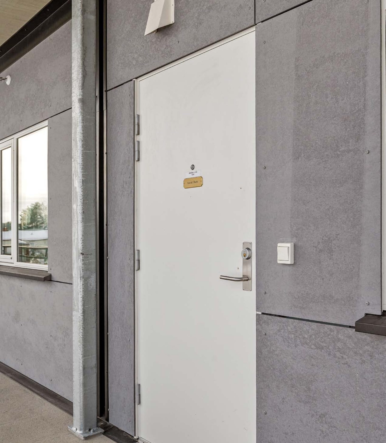
Tett entrédør som tar deg videre inn til leiligheten.
