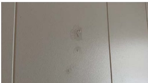
Bruk av fugemasse.
