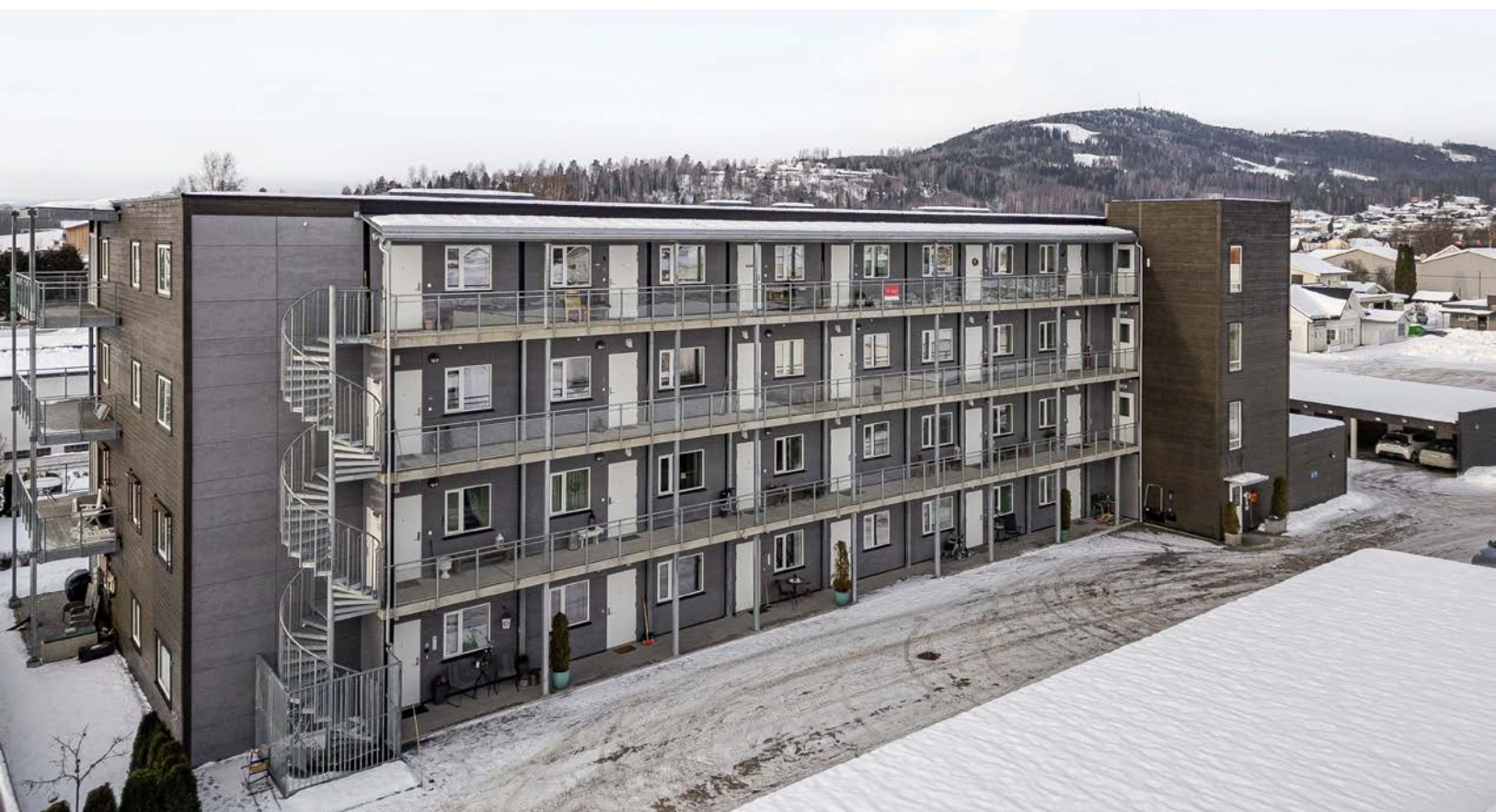
Bakgård med asfalterte områder, carportanlegg og boder.
