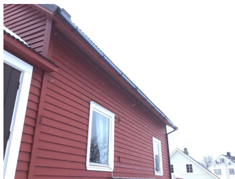
Takrenne mot nord
