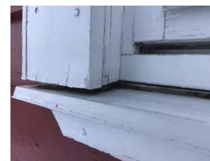
Utettheter under kant vindu
