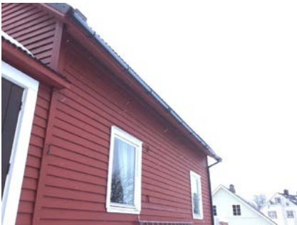
Takrenne mot nord
