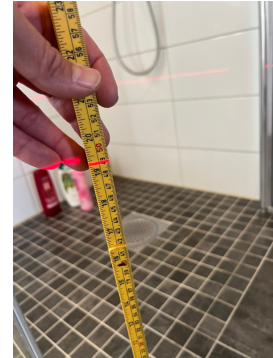
Målt høyde 49 cm ved kant dusjsone, baderomsgulv er da flatt
