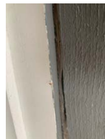
Glipe mellom utv. utforing og karm
