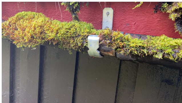
Lekkasje i skjøter
