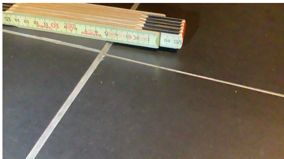
Sprang mellom fliser.
