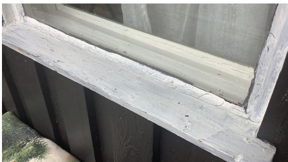
Vindusramme er listet inn og fuget i åpning i vegg.
