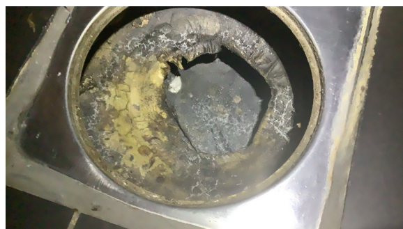
Plastsluk i dusj uten klemring.
