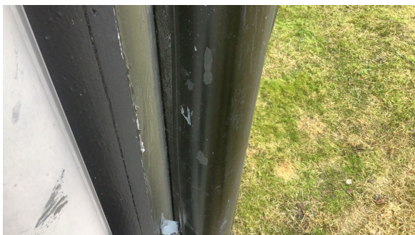
Frostsprengt nedløpsrør.
