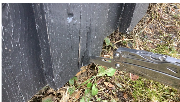
Råteskadet kledning.
