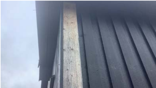
Ubehandlet kledningsbord.
