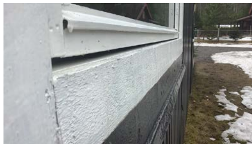
Dekkbord er montert utenpå karm mellom vindu og vannbrett.
