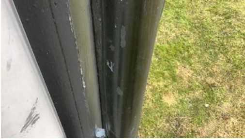
Frostsprengt nedløpsrør.
