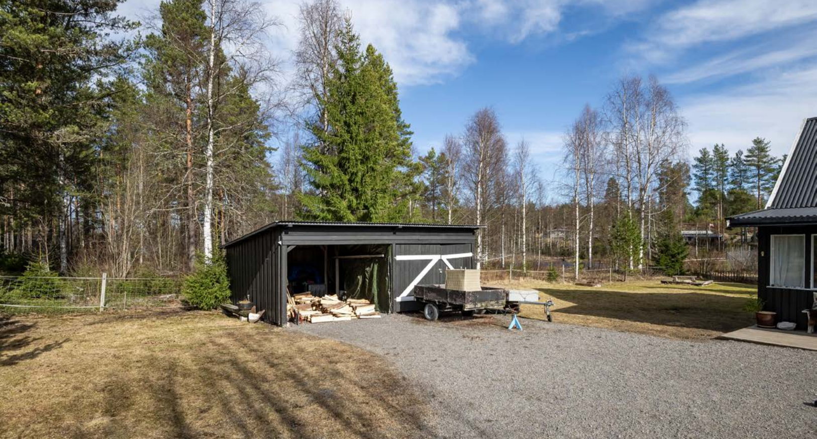
Garasjen er fra 1989, har grusdekke og bindingsverksvegger.
