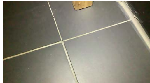
Ujevne flisfuger.
