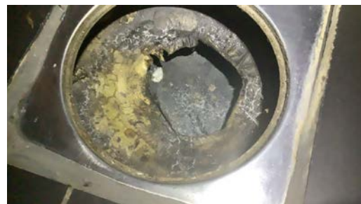
Plastsluk i dusj uten klemring.
