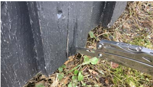
Råteskadet kledning.
