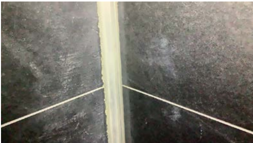
Hjørnelist tetter ikke mot plate
