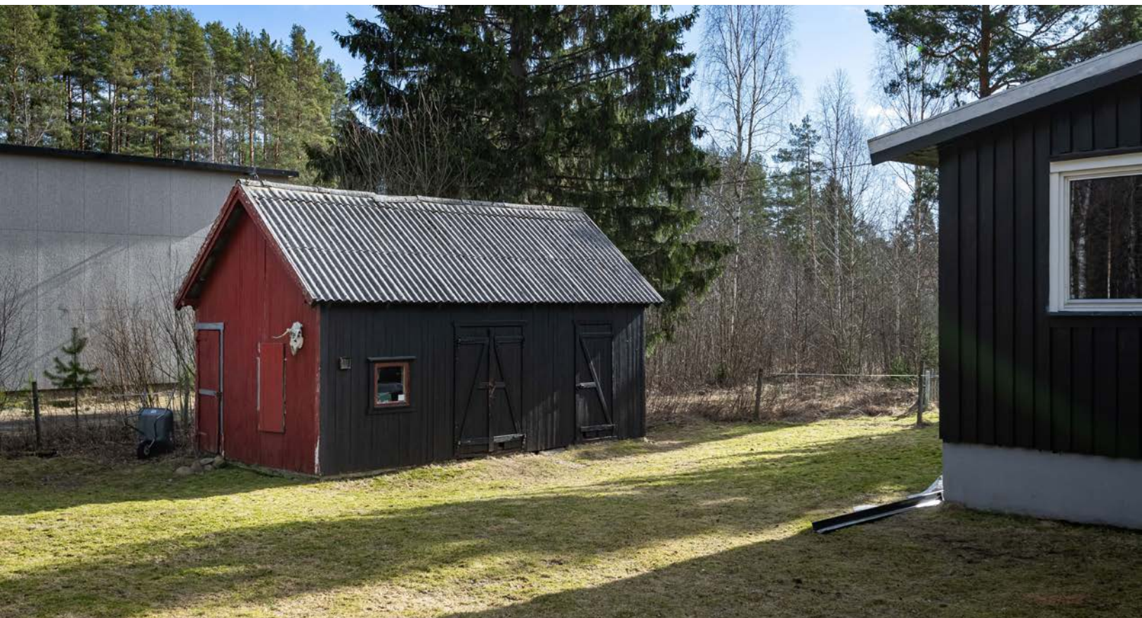
Uthus fra 1945 med tre bodrom, delvis oppført på betongringmur og har stående bordkledning.
