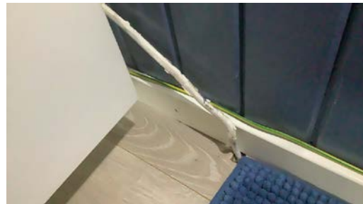
Eksempel på løs kabel.
