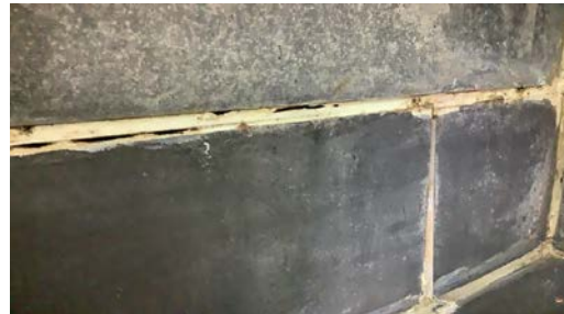
Utett silikonefuge mellom platebunn og sokkellist i dusjen.
