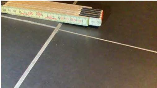
Sprang mellom fliser.
