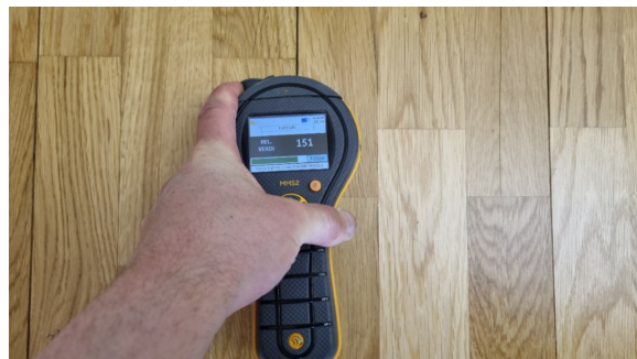
Det ble ikke registrert forhøyde fuktverdier ved befarings.
