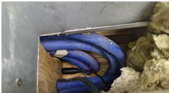
Fuktmåling i bunnsvill.
