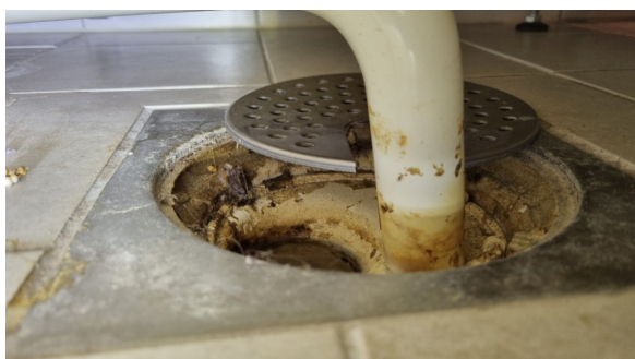
Kontroll av sluk.
