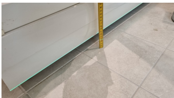
Gulvet har svakt fall til sluk.
