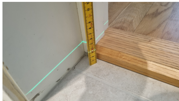
Kontroll av fall.
