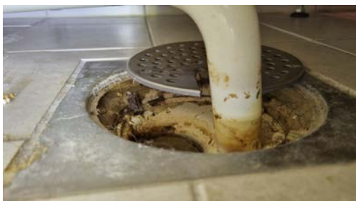
Kontroll av sluk.
