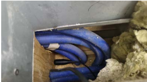
Fuktmåling i bunnsvill.
