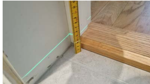
Kontroll av fall.
