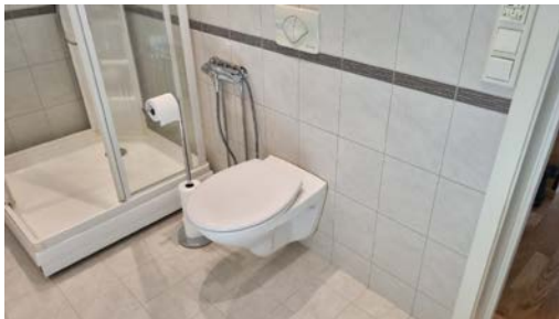
Manglende drengåpning under den innebygde sisternen.
