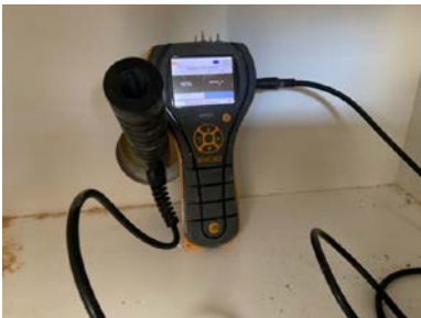
Fuktmåling i vegg ved hulltaking.
