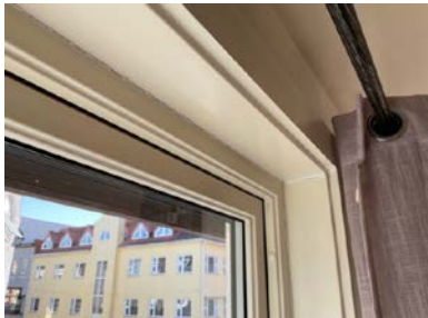
Sprekker mellom foring og list
