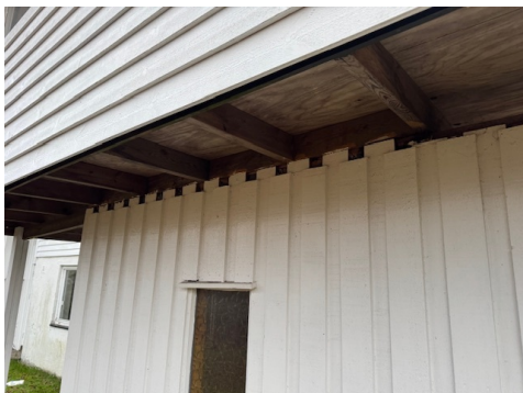
noe gjenstående arbeider
