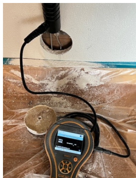
Fuktmåling i vegg mot våtsone.
