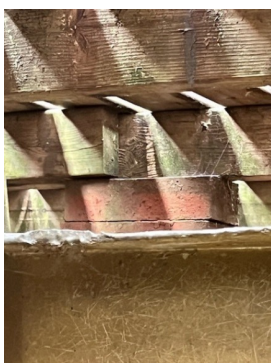
Terrasse med løs fundamentering.
