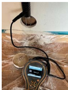
Fuktmåling i vegg mot våtzone.
