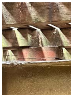
Terrasse med løs fundamentering.
