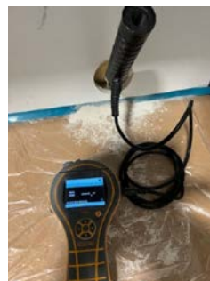
Fuktmåling i vegg mot våtsone.
