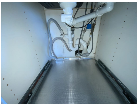
Besiktigelse av røropplegg.
