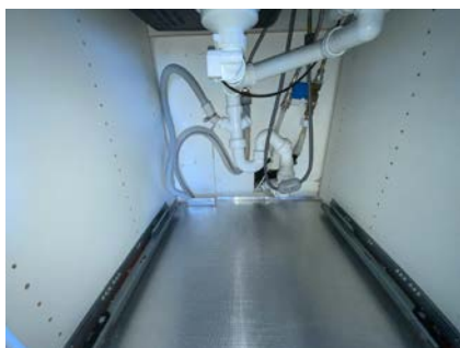
Besiktigelse av røropplegg.
