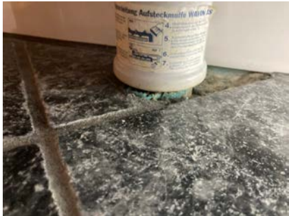
Avløp til vask, går i rør gjennom gulv
