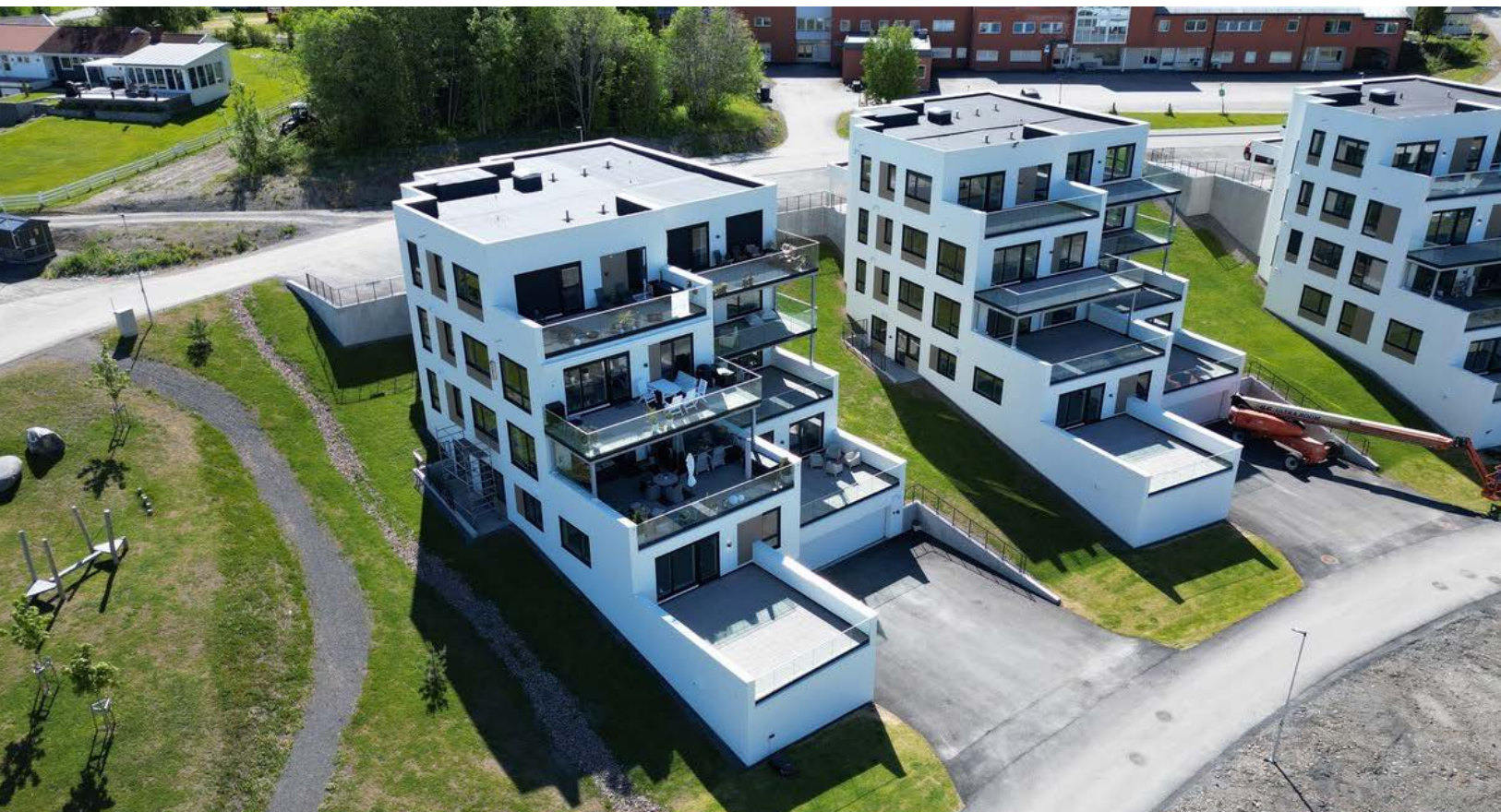
Fasade bygg I
