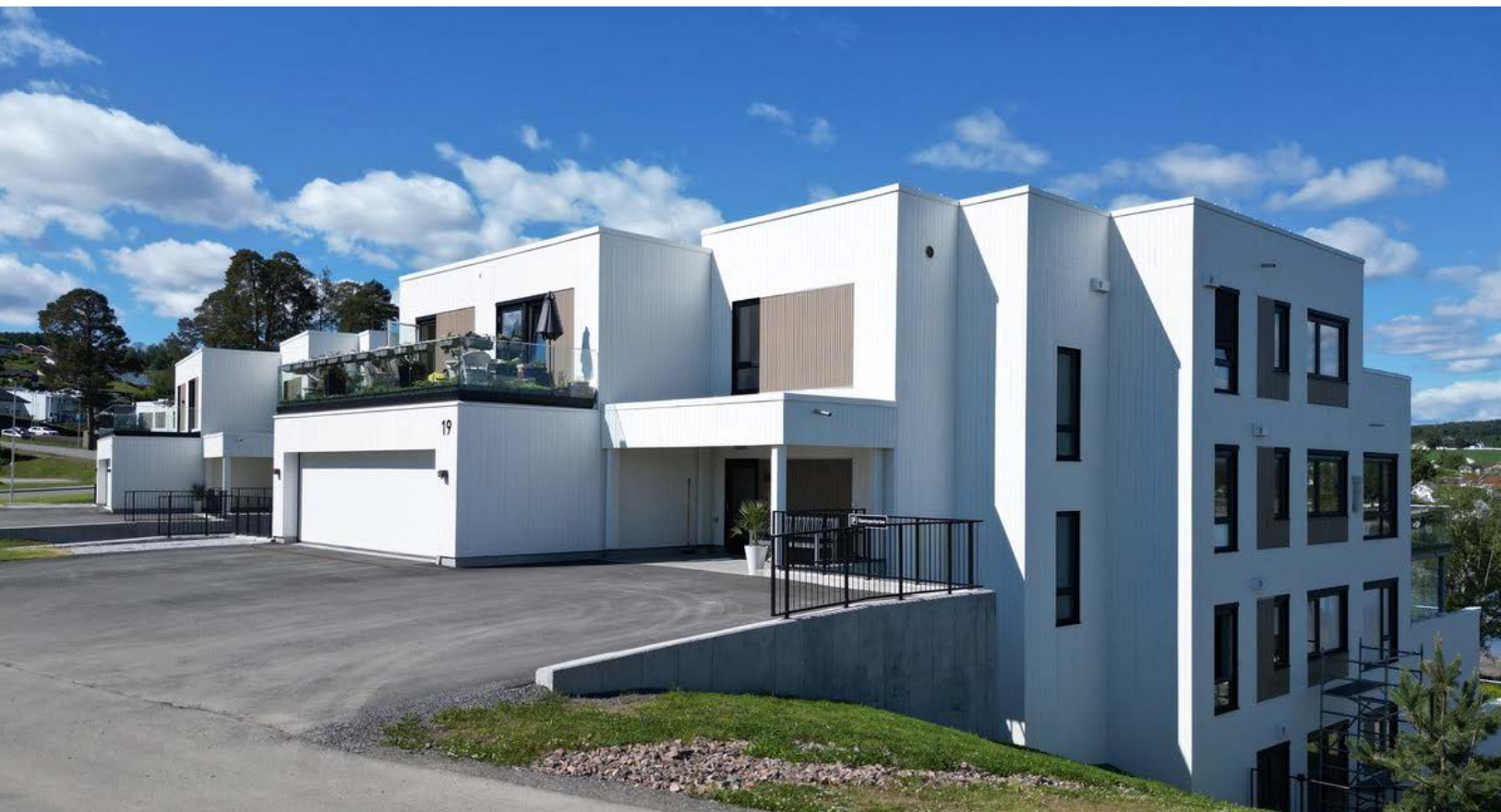
Fasade Smørvika bygg I
