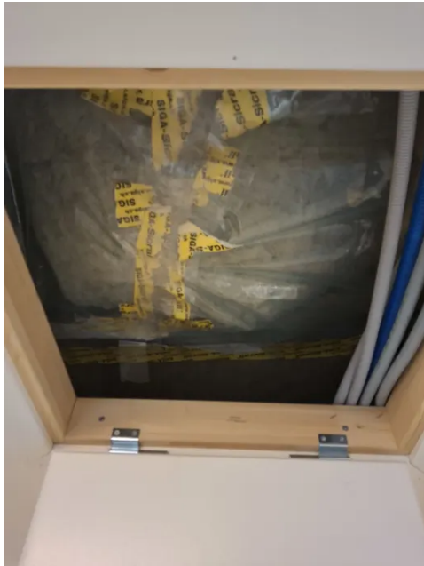
Inspeksjonsluke er plassert i gang.
