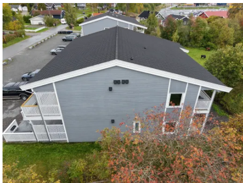
Boligen er oppført med saltakskonstruksjon.
