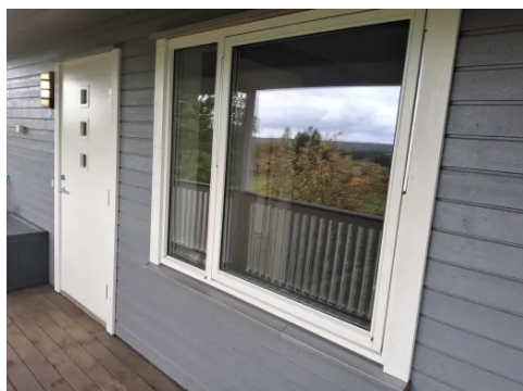
Leiligheten har entrédør med glassfelter og vinduer med karm av tre og tre-lags glass.
