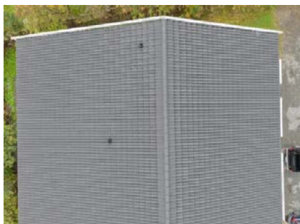
Taket er tekket med betongstein.
