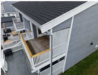
Boligen har takrenner og nedløpsrør i metall.
