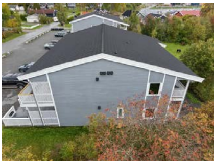
Boligen er oppført med saltakskonstruksjon.
