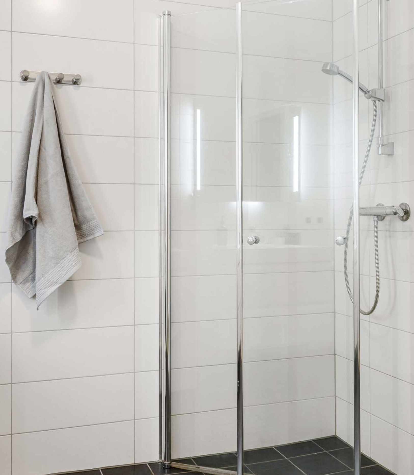
Dusjhjørne med innfellbare dusjdører og veggmontert dusjbatteri.
