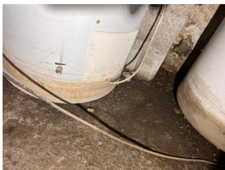
Kjeller med adkomst fra vaskerommet, vannstand vises på bereder.
