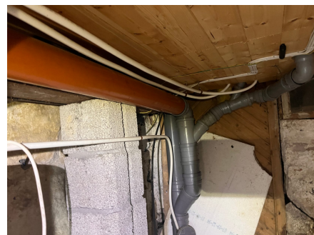
Rør er dårlig festet på deler av anlegget.
