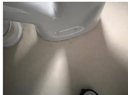
Hull tettet med fugemasse.
