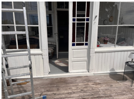
Noe slitte overflater på gulvbord.
