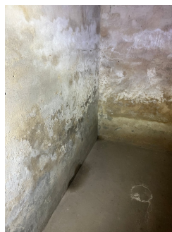
Kjeller med adkomst fra innglasset balkong.
