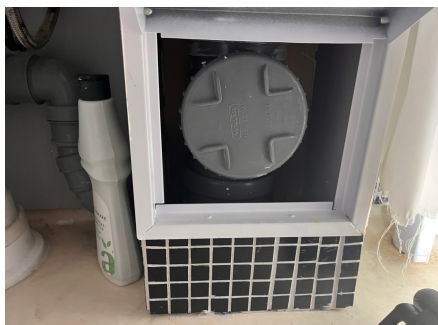
Stakeluke på bad i 2 etasje.
