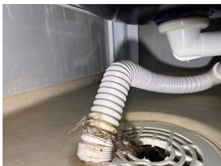
Ikke fuget i underkant av veggplater.
