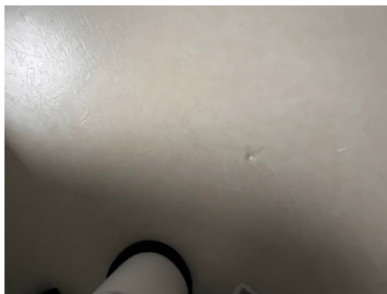
Hull tettet med fugemasse.
