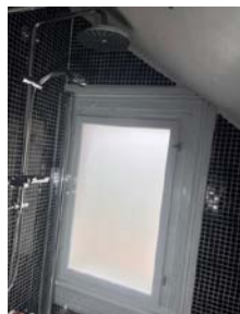
Glassvegg dekker ikke hele vinduet.
