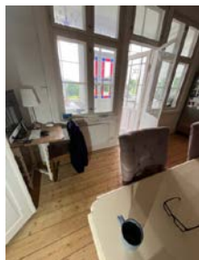
Innslående dørblad med enkle glass i glassveranda mot sørvest.
