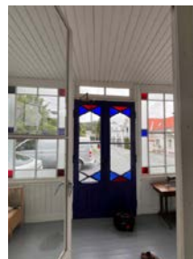
Innslående ytterdør mot nordøst.
