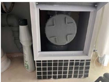
Stakeluke på bad i 2 etasje.
