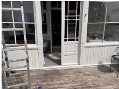
Innslående dørblad med enkle glass i glassveranda mot sørvest.
