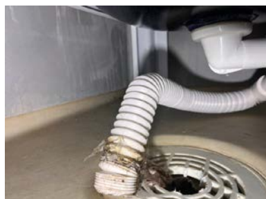
Ikke fuget i underkant av veggplater.
