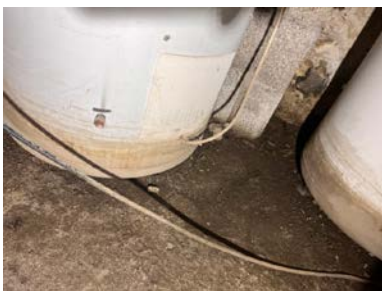
Kjeller med adkomst fra vaskerommet, vannstand vises på bereder.
