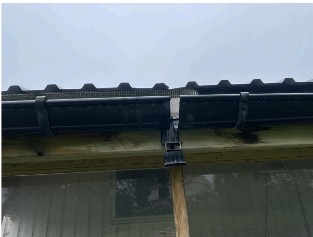
Ødelagte skjøtebeslag.
