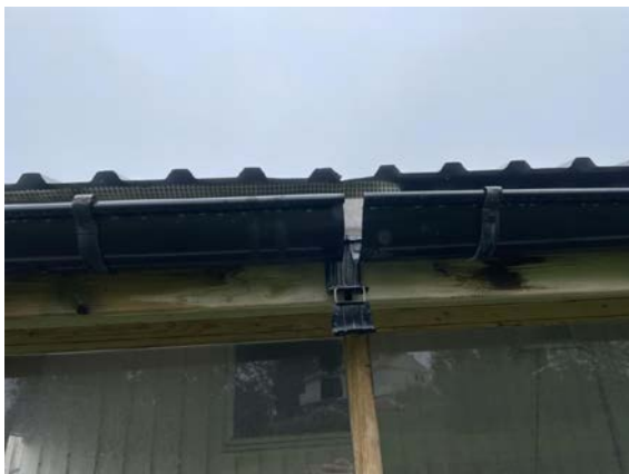
Ødelagte skjøtebeslag.
