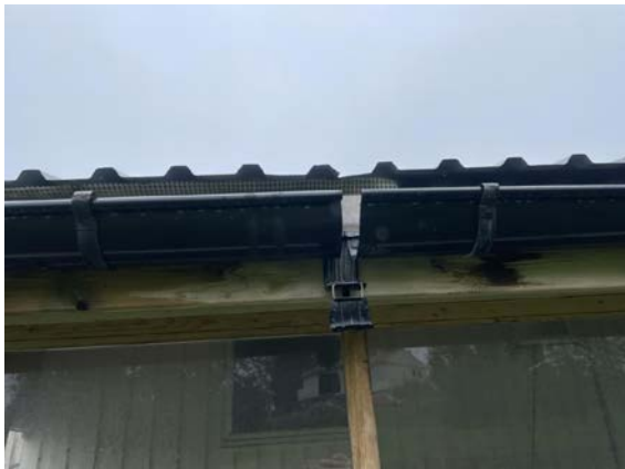
Ødelagte skjøtebeslag.
