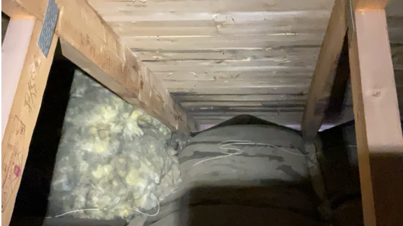
Lufting mot raft er delvis dekket av isolasjon.
