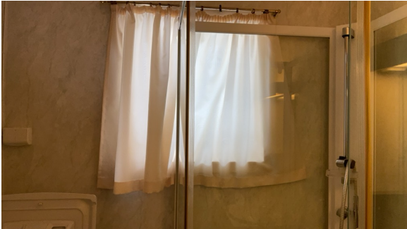
Vindu plassert i våtsone.
