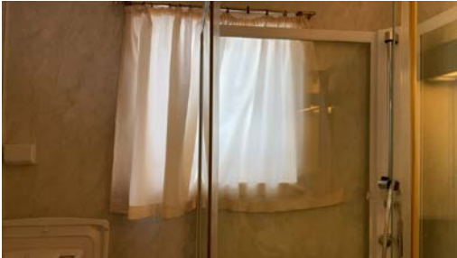
Vindu plassert i våtzone.
