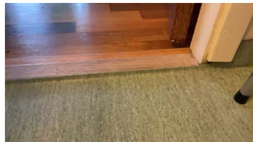
Målt oppbrett ved terskel: 10mm.
