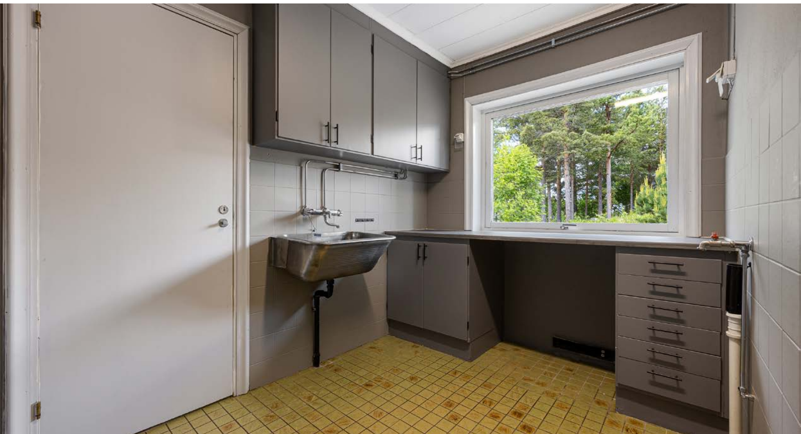
Praktisk vaskerom med gule fliser på gulv med vannbåren gulvvarme, gråmalte veggflater, et vindu og hvitmalt himling. Innredet med skyllekum, benkeinnredning og opplegg for vaskemaskin.
