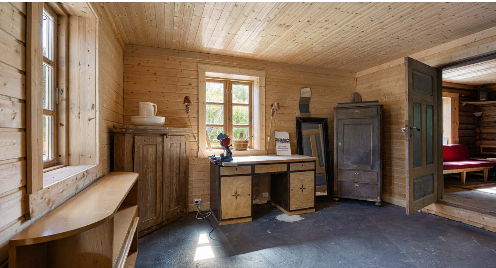
Det ytterste rommet har vegger kledd i panel, og begge har støpt gulv, panel i taket, nyere sprossvinduer og innlagt strøm.
