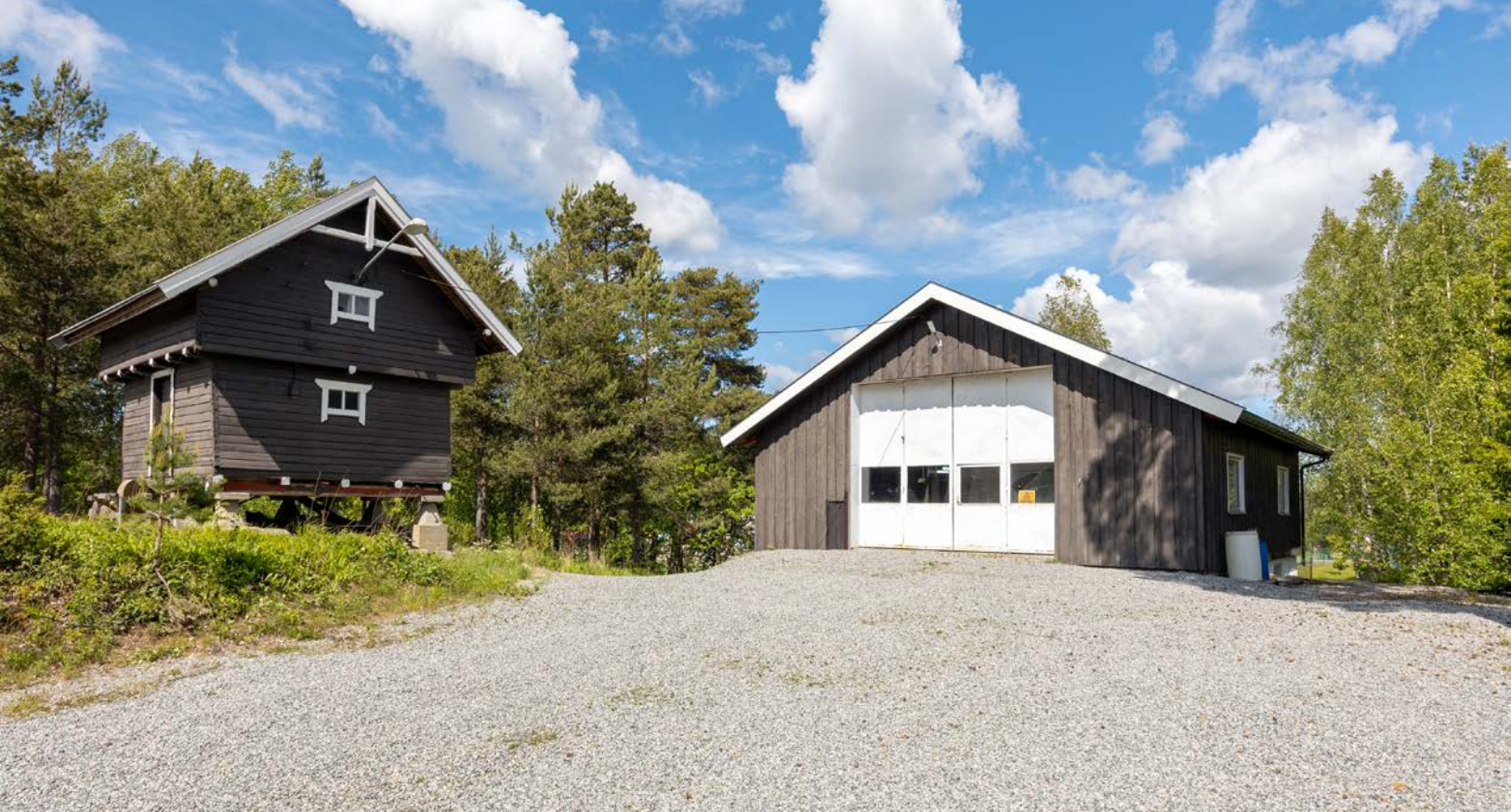
Stabburet er godt vedlikeholdt, i tradisjonell stil med brune laftevegger og hvitmalt staffasje. Både første etasjen og loftet har tregulv med trapp mellom og det er innlagt strøm.
