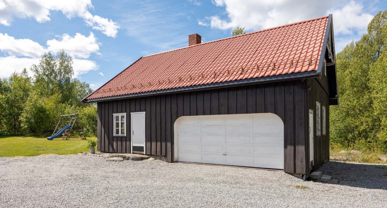
Bryggerhuset er det bygget som ligger nærmest boligen. Dette var opprinnelig et laftet bygg som i 1990 ble tilbygd med garasjedel.
