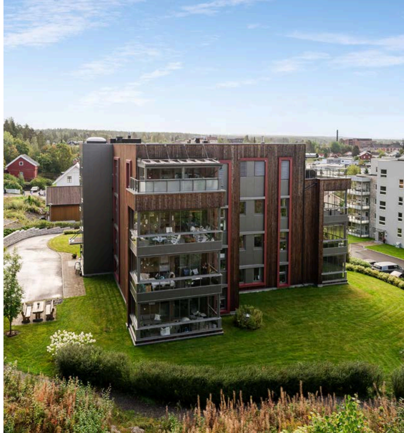
Sameiets fellesområde er pent og ryddig og opparbeidet med plen og diverse beplantning.
