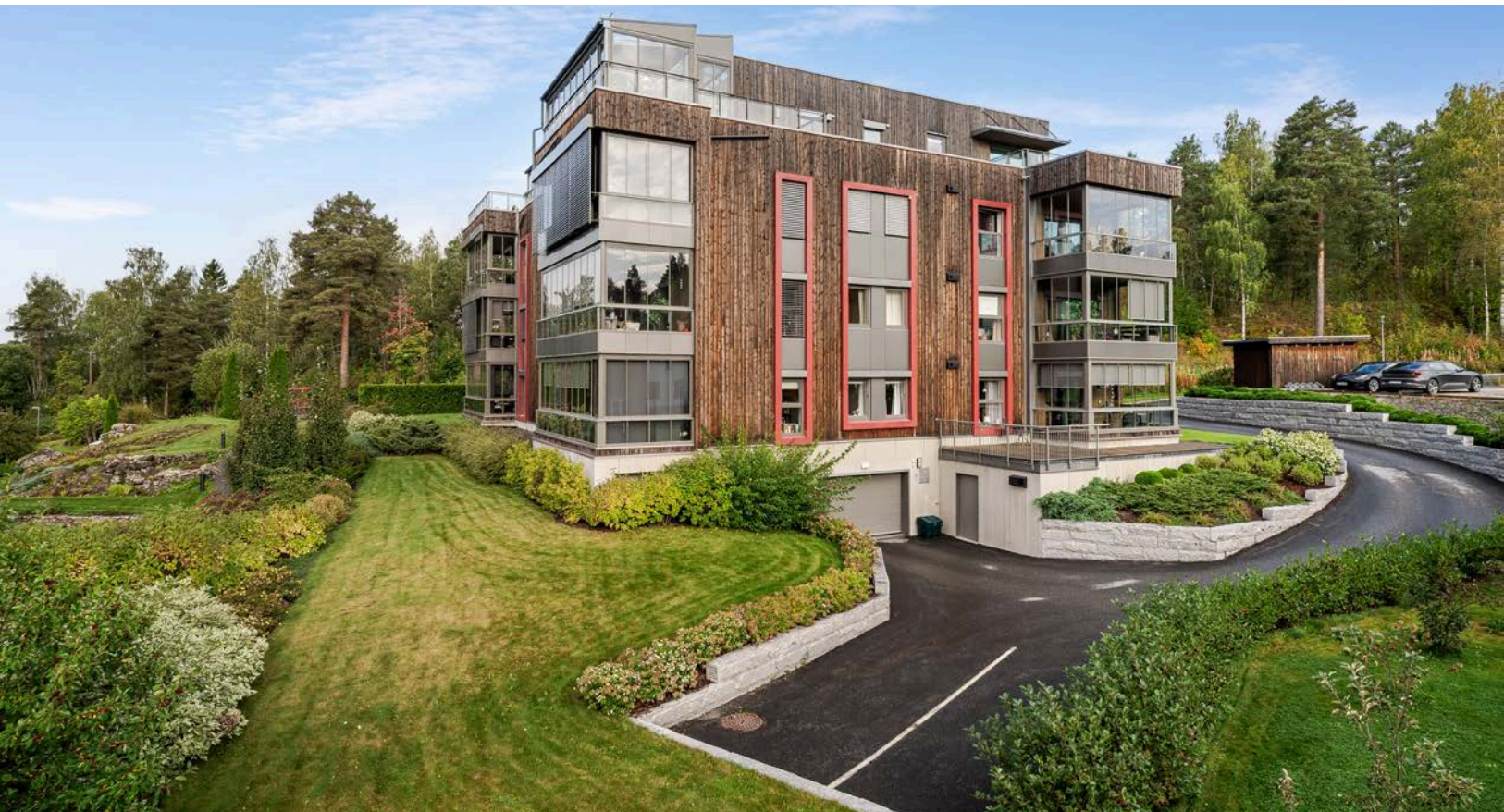
Asfaltert nedkjøring til felles garasje med boder.
