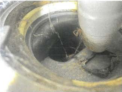
Bilde av sluk.
