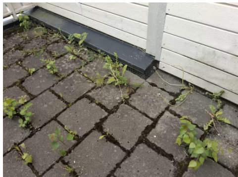
Det registreres synlig fuktsperre mot grunnmur.
