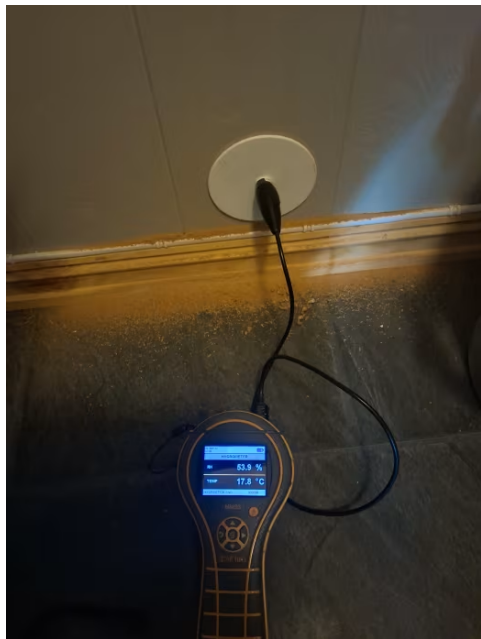
Bilde fra fuktmåling i utlektet veggkonstruksjon
